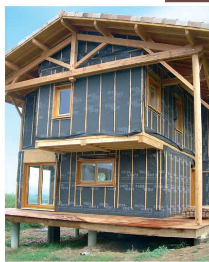
Chantier réalisé par les établissements Chambost (01)
