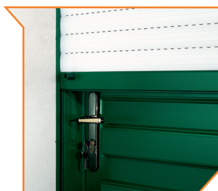
Tablier volet roulant avec coulisse intégrée dans le mur.
